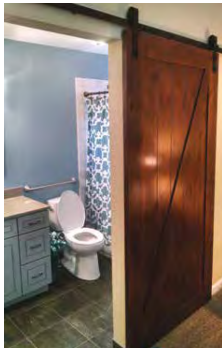
Door Widening Barn Door
